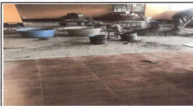
Foto 6: Sustitución por piso Cerámico aula 2
