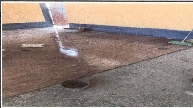
Foto7: Sustrucción por piso Cerámico aula 3
