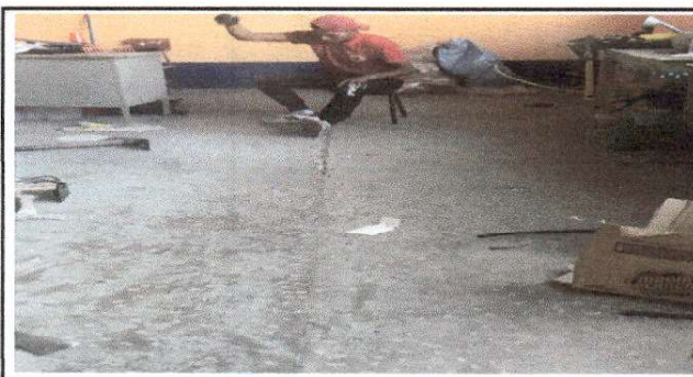
Foto 5: Sustitución por piso Cerámico aula 1
