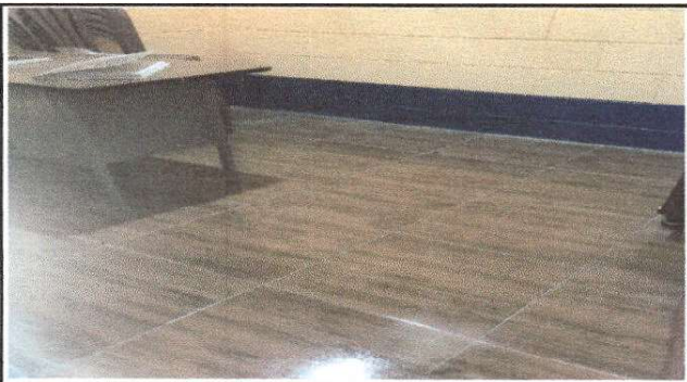
Foto9: Sustrucción por piso Cerámico Dirección
