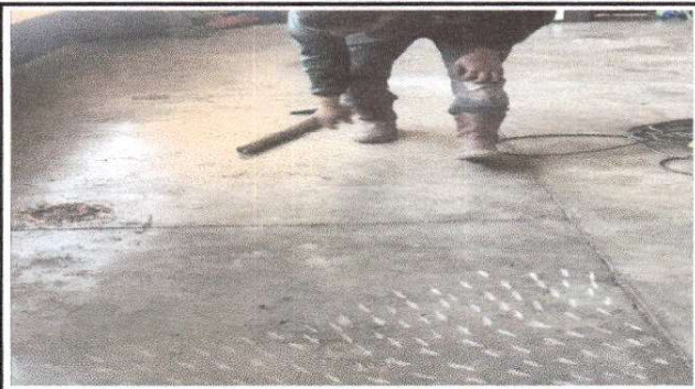
Foto 8: Sustrucción por piso Cerámico aula 4
